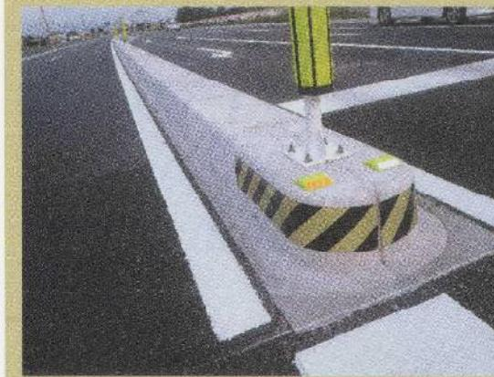
中央分離帯ブロック（群馬県1社1技術商品）「施工制と美観を追求」既存の縁石ブロックを組み立てての分離帯施工より40%の施工期間の短縮と施工費用の節減に成功
